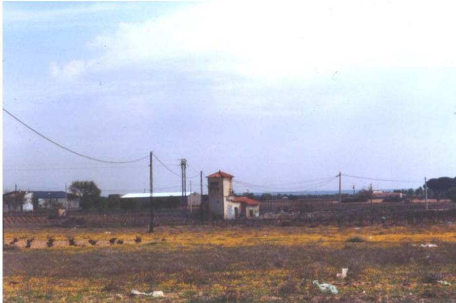
Foto 3.- Captación “Pozos de las Arenas” .
